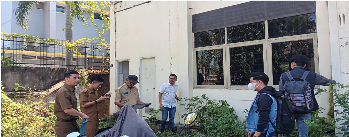
Keterangan: Kondisi Bangunan Gedung Badan Pendapatan Daerah sebelum renovasi (April tahun 2023)
